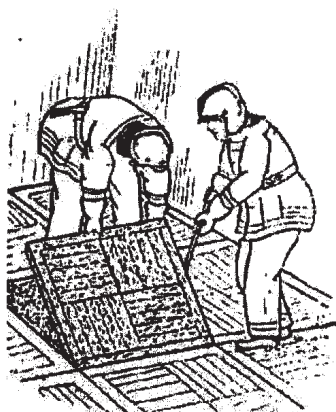
Рис. 8.12. Вскрытие щитового пола
